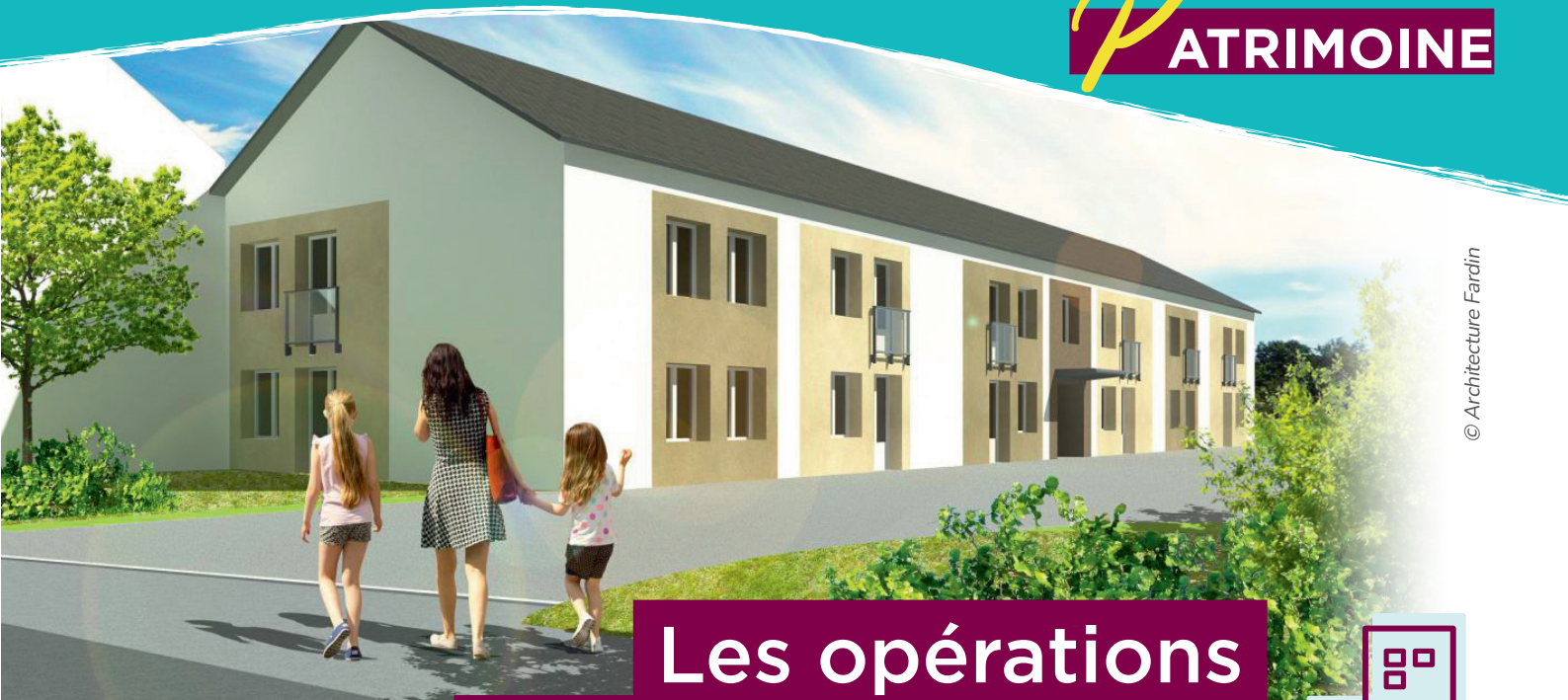
Les travaux de réhabilitation de l'immeuble St Charles à Nueil Les Aubiers vont débuter.
